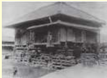
放水路の予定地となったため、 コロでひく準備をしている家 現在の墨田5丁目付近
