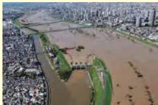
令和元(2019)年・台風19号による増水から 隅田川流域を守るため閉じた岩淵水門 提供：国土交通省 荒川下流河川事務所
